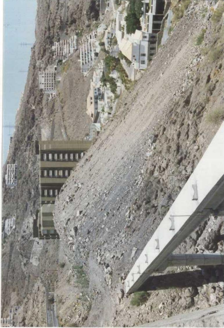
Fotografía 4 .- Deficiente ubicación de la estructura
